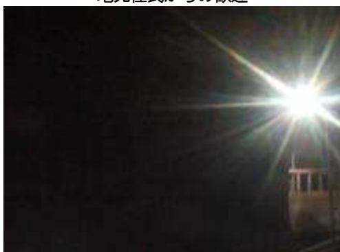
夜間に自動点灯する街路灯
