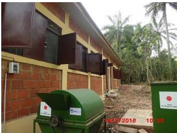
新設されたヤシ果実及びキャッサバ加工施設
